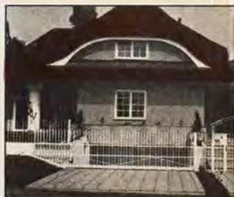
44. ábra Szépen kivitelezett, hidegen hengerelt zártszelvényből készített kerítés és kapuk
